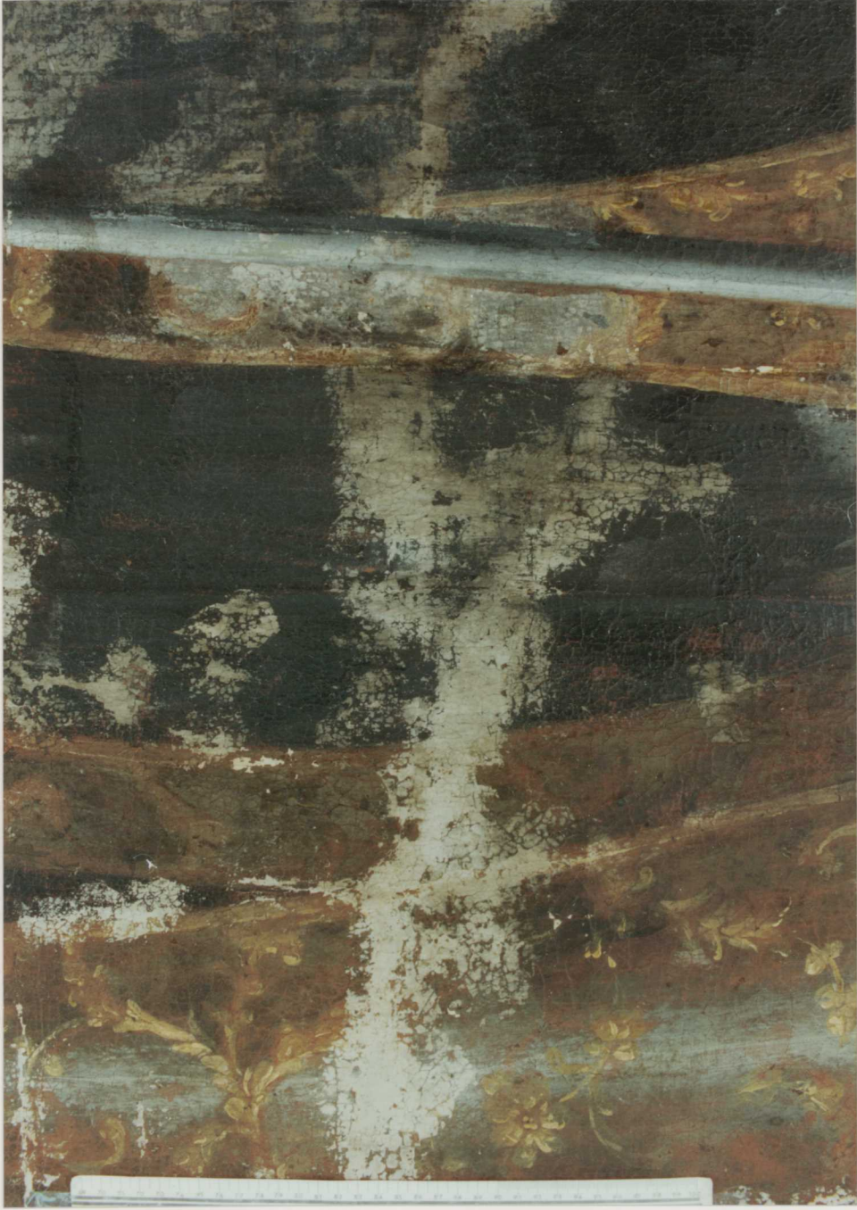
RÉSZLETFELVÉTEL KORÁBI TÖMÍTÉSEK DEMUTATÁSA LETISZÍTOTT FELÜLET
