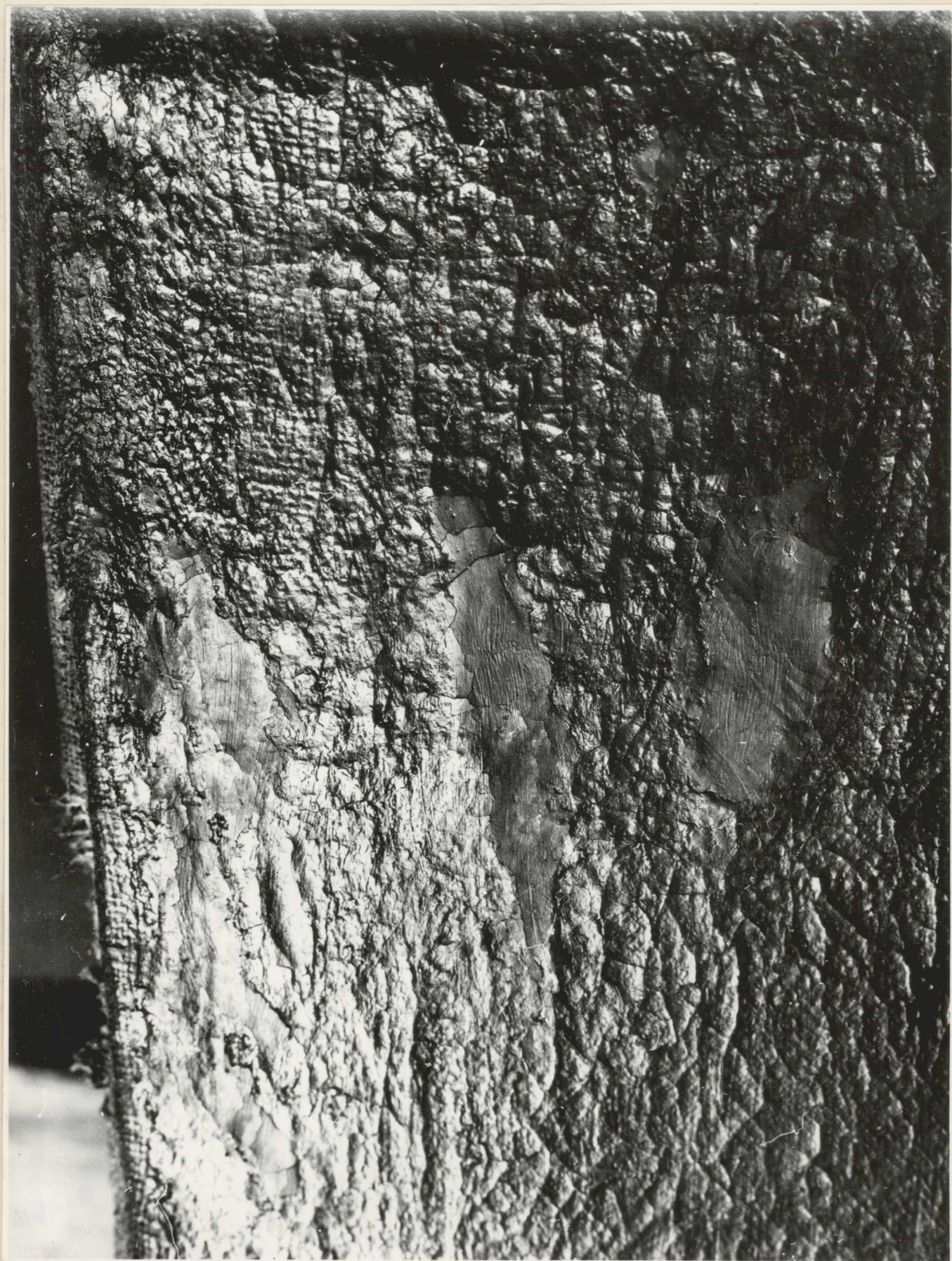
11. Előzetes beavatkozások nyomai - repedezett régi tömitések. /részlet/ 1976. X. 20.
